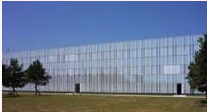
Centre hospitalier de Marne-la-Vallée 2, 4 cours de la Gondoire - 77600 Jossigny Téléphone : 01 61 10 61 10
