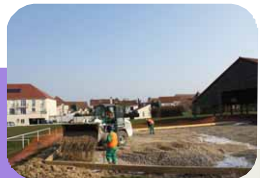
Mise en place du futur terrain de pétanque
